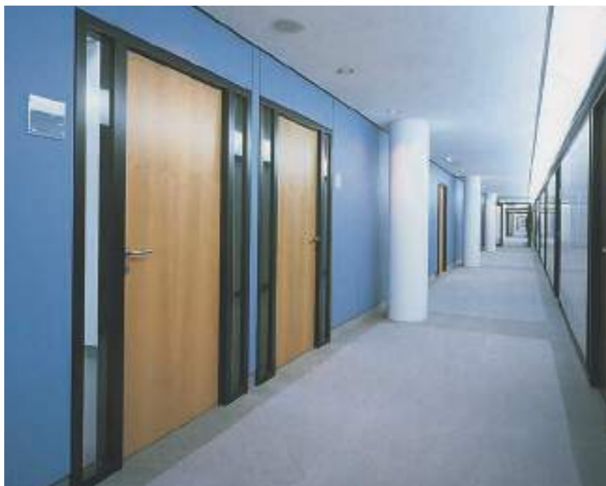
Telaio in acciaio inox a filo con battente e muro High-grade steel frame flush with door and wall
