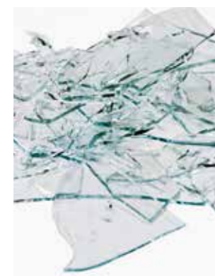
Rottura di un vetro non VSG
