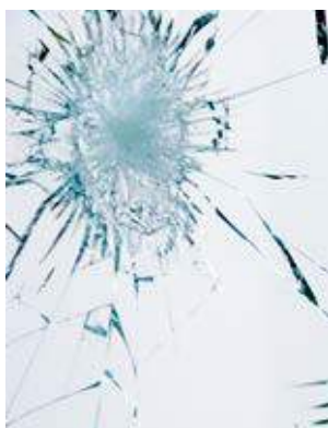
Rottura di un vetro VSG (vetro stratificato di sicurezza, vetro antischeggia)
